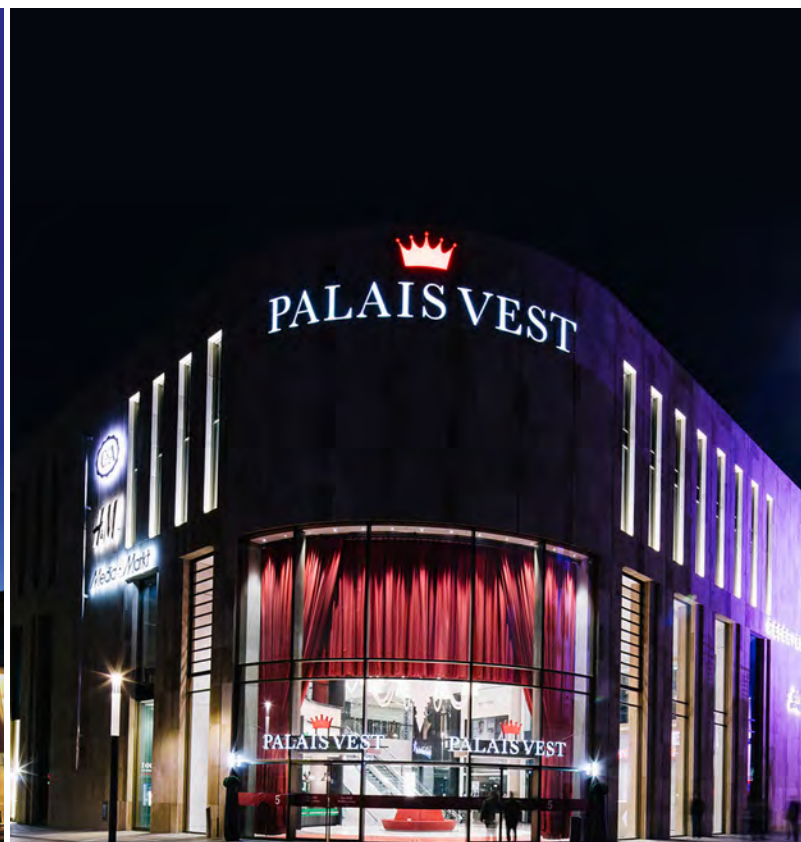
Palais Vest, Germany Architects: Auer + Weber + Assoziierte
